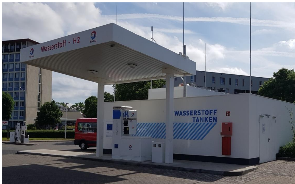
Abbildung 39: Wasserstofftankstelle in Dresden - Wiener Straße
