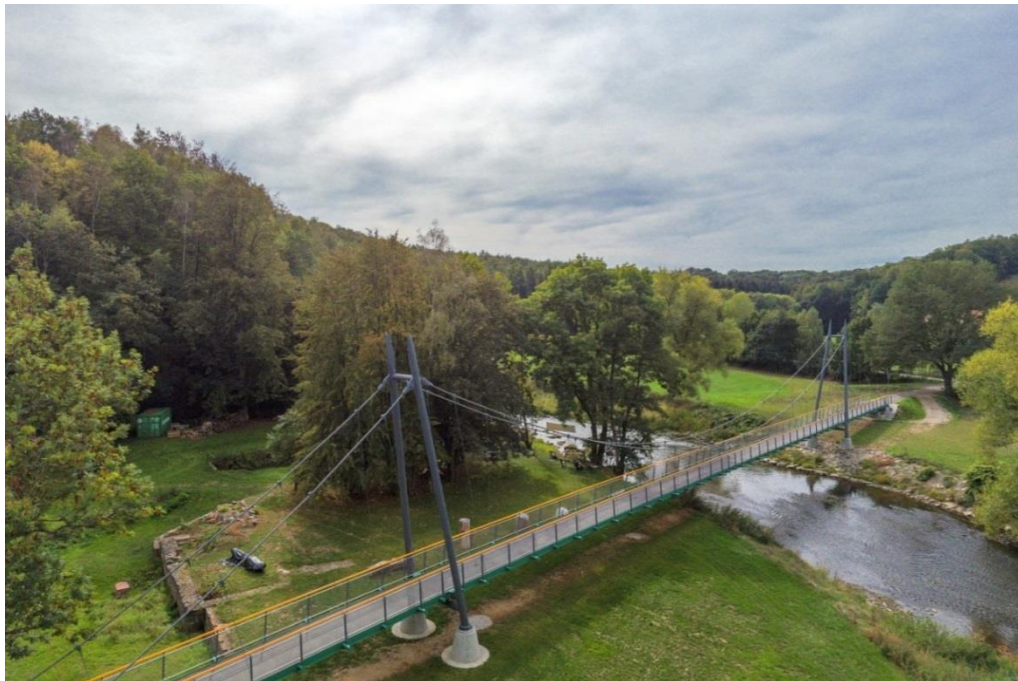
Abbildung 15: B 107 Chemnitztalradweg, Bauwerk 10
